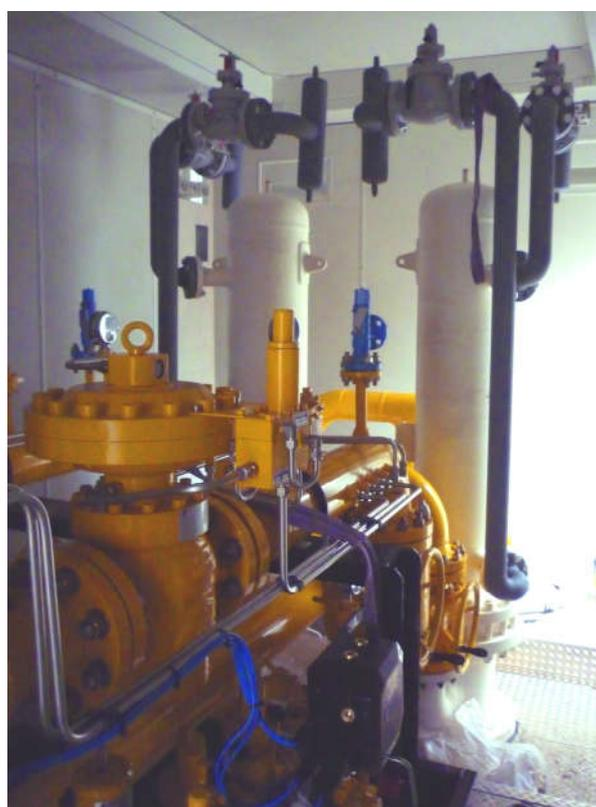
DERP Primária com o trocador de calor modelo GHE-BEU da GASCAT (126.000 KCAL/H)
